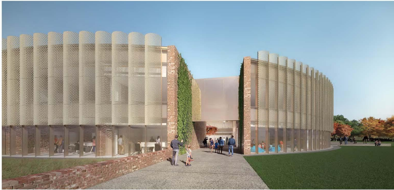
view looking south towards fieldhouse entry vista de la entrada a la casa de parquet hacia al sur
